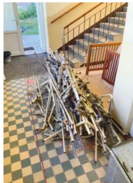
MŠ Markova - oprava III. pavilonu
