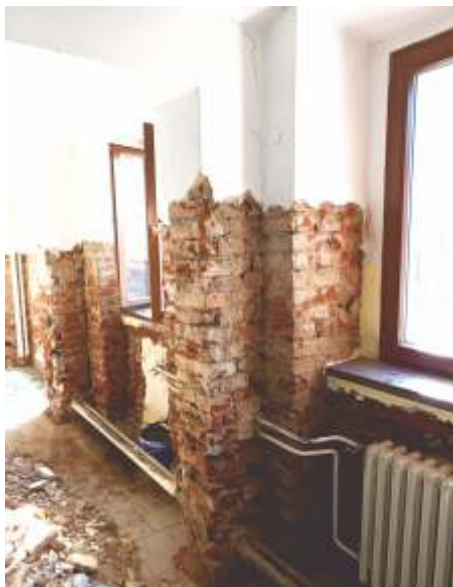
obnažené zdivo ve školních šatnách - zahájení II. etapy sanace
