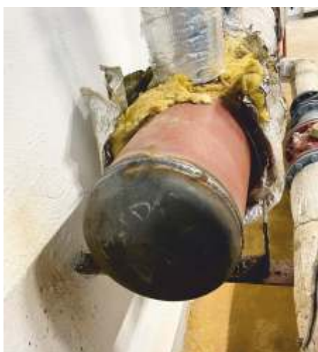
výměna bočního víka rozvaděče TUV
