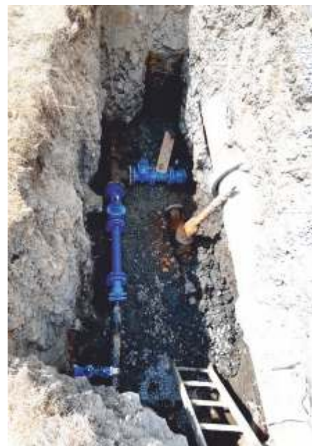
výměna šoupátek - Hluboká
