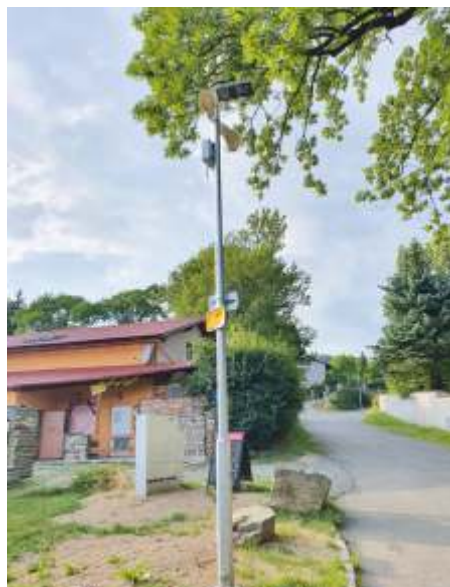
modernizace VO - ul. Farní
