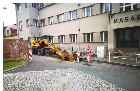
oprava hloubkové kanalizace u MZŠ Kdyně, která rovněž souvisí s vlhkostí budovy
