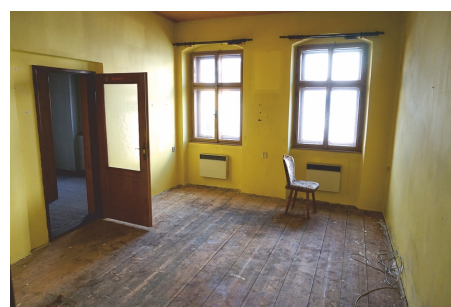
byt nad restaurací U Jána před rekonstrukcí
