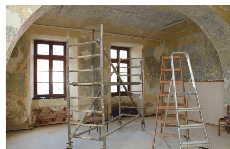
sanace v přízemí radnice - budoucí kanceláře Odboru správy nemovitostí MěÚ Kdyně
