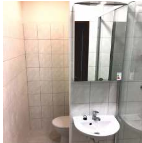
bytová jednotka po rekonstrukci
