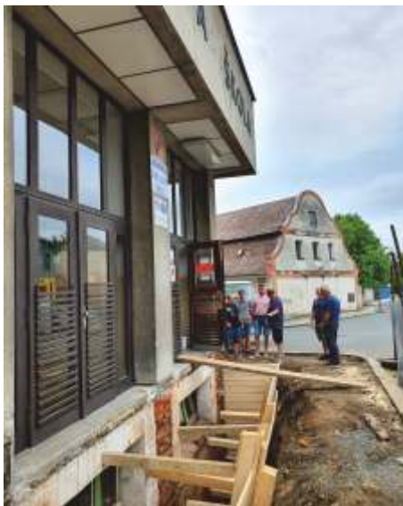
sanační práce v budově MZŠ Kdyně
