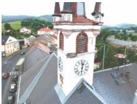
radniční věž – foto z průzkumu dronem
