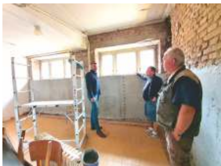
sanační práce v budově MZŠ Kdyně – zázemí školní kuchyně
