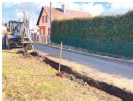
rekonstrukce vodovodu v obci Starec – výkopové práce
