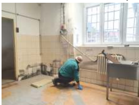
sanační práce v budově MZŠ Kdyně – školní kuchyně
