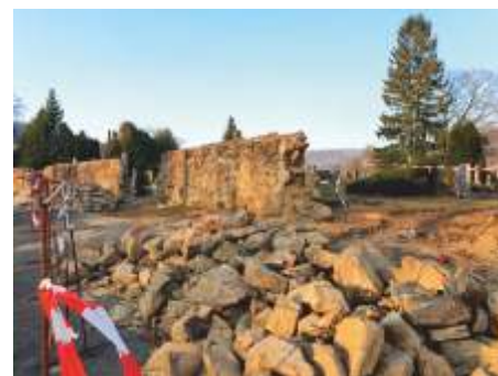
průběh rekonstrukce hřbitovní zdi – březen 2022
