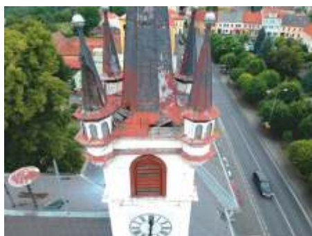
radniční věž – foto z průzkumu dronem
