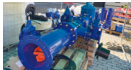
Příprava armatur litina DN 250 na suchu – červenec 2025
