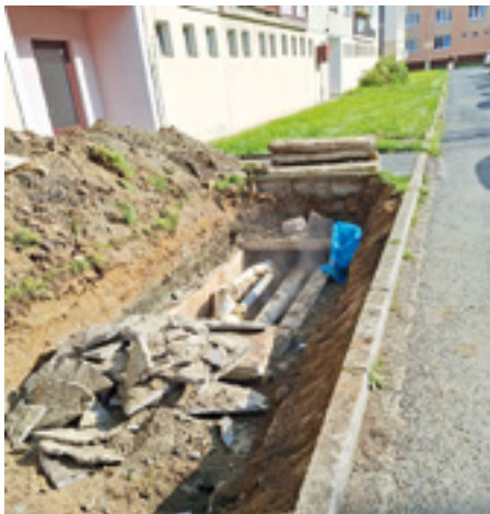
Oprava topení - křižovatka ulic Na Koželužně – Mlýnská
