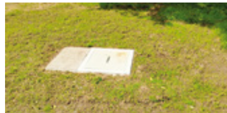
Nová šachta - Na Koželužně 619
